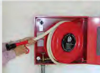
**3. ABRA LENTAMENTE LA LLAVE DE PASO DE LA MANGUERA ASEGURÁNDOSE DE QUE LA LANZA O BOCA DE SALIDA ESTÉ EN SU POSICIÓN DE CERRADA.**
