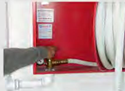
**4. ABRA LA LANZA O BOCA DE SALIDA DE LA MANGUERA EN LA POSICIÓN DE SEADA:**
